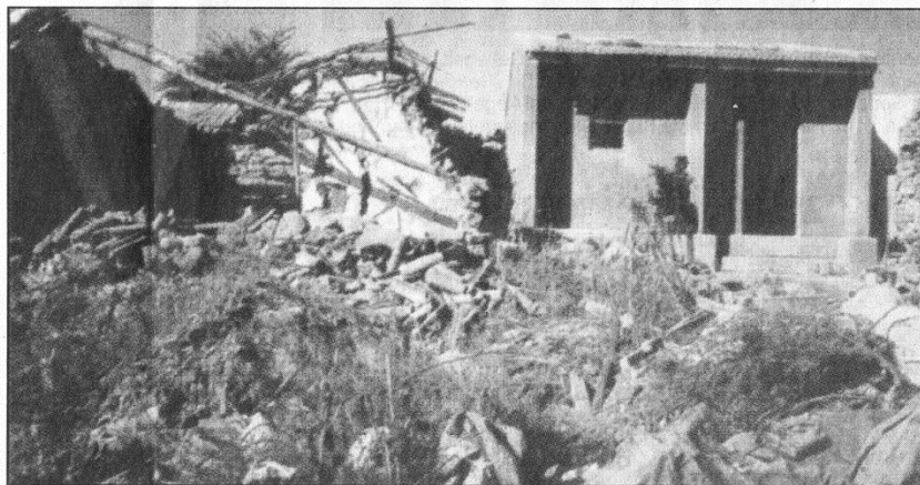
Ein neues, erdbebensicheres neben einem zerstörten Haus: Großzügige Spenden aus Dülmen haben dazu beigetragen, dass die zahlreichen Erdbebenopfer in Indien ein neues Zuhause haben.
